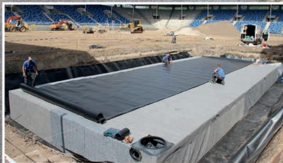
Abbildung zeigt Retention mit EcoBloc Inspect + Folie
