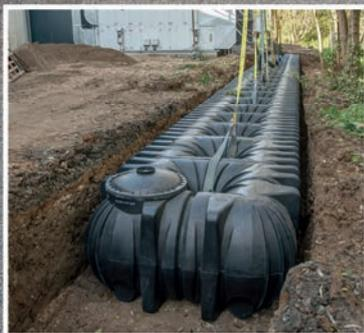
Abbildung zeigt Platin XXL Retentionstank 65.000 Liter
