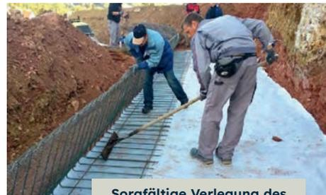
Sorgfältige Verlegung des Erosionsschutzgitters
