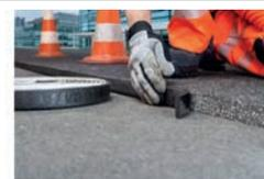
TOK®-Band SK N2 ist ein hochwertiges, polymervergütetes selbstklebendes Bitumenfugenband, speziell für die kälteren Monate. TOK®-Band SK N2 ist einseitig mit einem hoch wirksamen Haftkleber vollflächig beschichtet. Zur sicheren Verlegung ist die zum neu eingebauten Asphalt gekehrte Bandseite durch ein gut sichtbares Wellenmuster gekennzeichnet.
