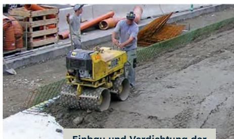
Einbau und Verdichtung der ersten Füllschicht
