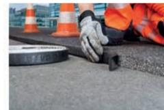
TOK®-Band SK ist ein hochwertiges, polymervergütetes, selbstklebendes Bitumenfugenband mit sehr guten Dehnungs- und Hafteigenschaften. TOK®-Band SK ist auf einer Seite vollflächig mit einem hoch wirksamen Haftkleber VOLLFLÄCHIG ausgerüstet.
